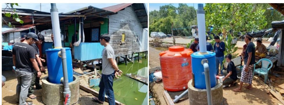
Gambar 2. Persiapan pemasangan teknologi tepat guna jamban
